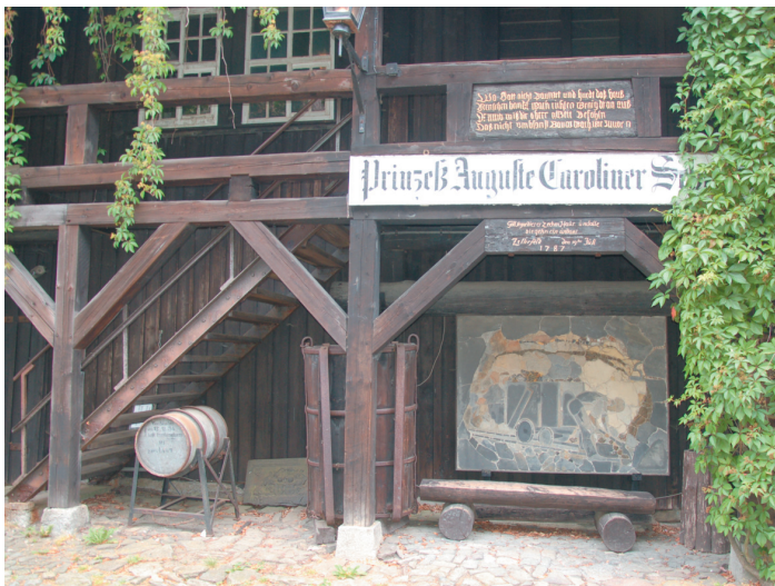
Ryc. 3. Wejście do trasy podziemnej w Clausthal-Zellerfeld
