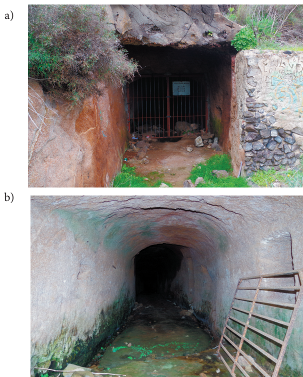
Ryc. 5. Sztolnia w Barranco del Chafariz; a) wlot wyrobiska drążonego w pokładzie tufu, w stropie widoczny bazalt, b) wstępny odcinek sztolni
