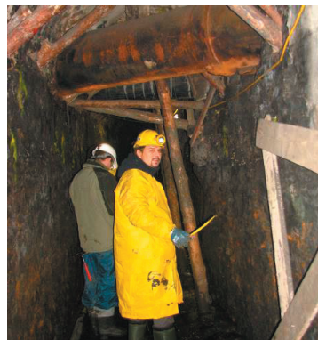
Ryc. 7. Przykłady prowadzenie inwentaryzacji i oceny makroskopowej elementów obudowy wyrobiska (Główna Kluczowa Sztolnia Dziedziczna w Zabrze i Kopalnia Ćwiczebna „Szygarka” w Dąbrowie Górniczej)
