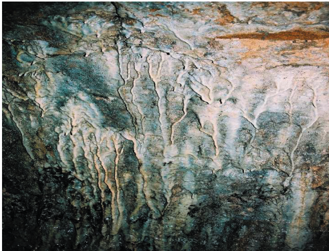
Ryc. 2. Draperie na obudowie kamiennej utworzone z wypłukanego z zaprawy węglań wapienia (Główna Kluczowa Sztolnia Dziedziczna w Zabrze)
