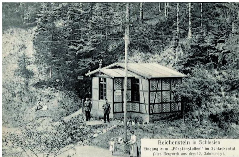
Ryc. 9. Domek przy wylocie Sztolni Książęcej, początek XX w.; wydawca pocztówki zamieścił adnotację „Złoty Stok na Śląsku. Wejście do Sztolni Książęcej w Dolinie Żużłowej. Dawne wyrobisko z XII wieku” (zbiory E. Szumskiej, Kopalnia Złota w Złotym Stoku)
