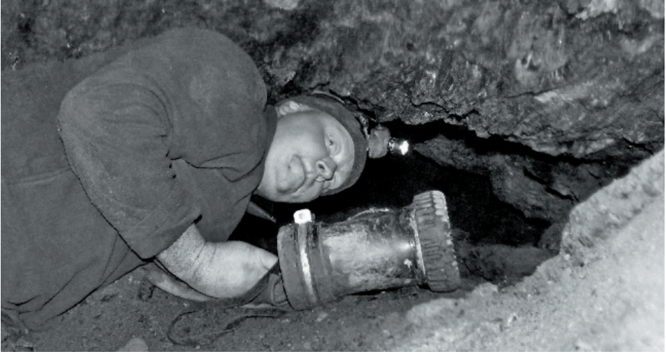
Ryc. 4. Zniszczona część wyrobiska podczas badań Fig. 4. Investigation of wear out part of adit
