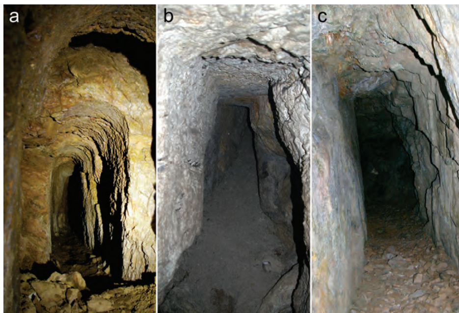
Ryc. 112. Różnicowanie przekrojów poprzecznych przykładowych wyrobisk z terenu Sudetów: a – Erbstollen w Złotym stoku , b – kopalnia Amalie w Srebrnej Górze , c – Gesellen Glückstolle w Ciechanowicach , o formie narzuconej przez cechy górotworu (wysokość sztolni – około 2 m) (fot. K. Zagożdżon)
