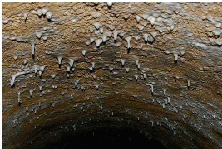
Ryc. 80. Liczne, krótkie nacieki kaltemitowe na tynku pokrywającym strop – sztolnia Porfirowa
